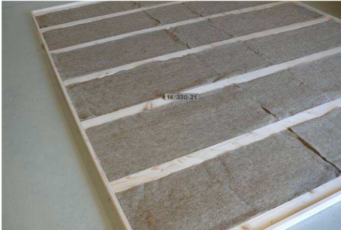
Bild 1: Rahmenkonstruktion mit Bedämpfung
