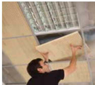
Mitte: Sanierung von Werkstattsräumen eines Sachverständigenbüros in Rottweil: LIGNO Akustik light 3S_33 im Rasterdeckenzuschnitt.
