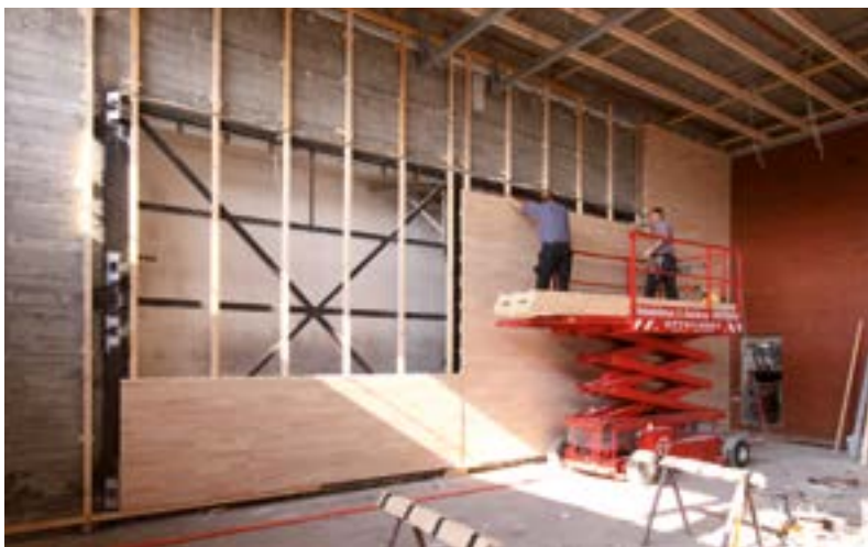
Bild unten: Unterkonstruktion mit Konstruktionsprofil uni*versa St-74 von Lignotrend an Nonius-Abhängern. Verborgene Befestigung der Elemente im Bereich von Feder/Kamm.
