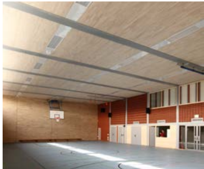
Bild oben rechts LIGNO Akustik light 3S_62 an Wand und Decke. Für die Decke wurde das Leistenprofil 625-25-8 mit 8 mm-Fuge gewählt, für die Wand das Profil 625-12-4 mit 4 mm-Fuge – teilweise reflektierend, um für die Verständlichkeit positive Schallreflexionen zu ermöglichen.
