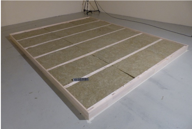
Bild 1: Rahmenkonstruktion mit Bedämpfung
