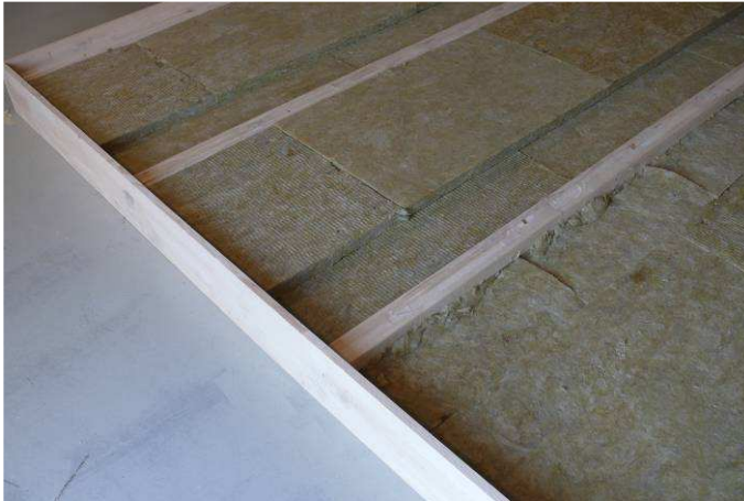
Bild 1: Rahmenkonstruktion mit Dämmstoff
