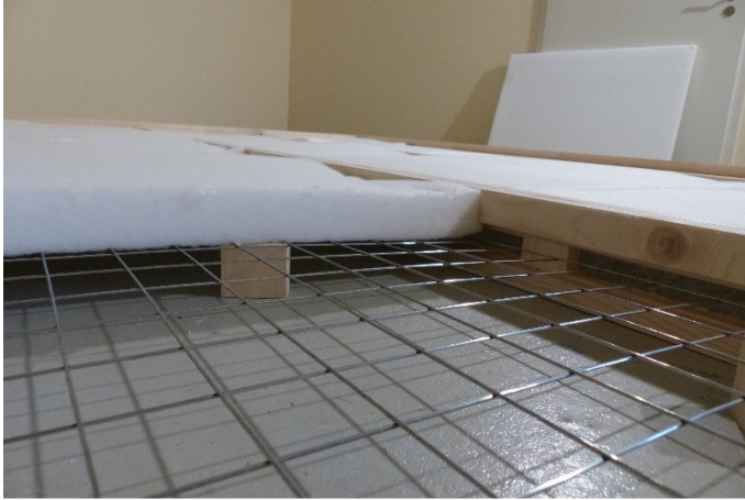
Bild 1: Rahmen mit Tragkonstruktion, Estrichmatte und Bedämpfung
