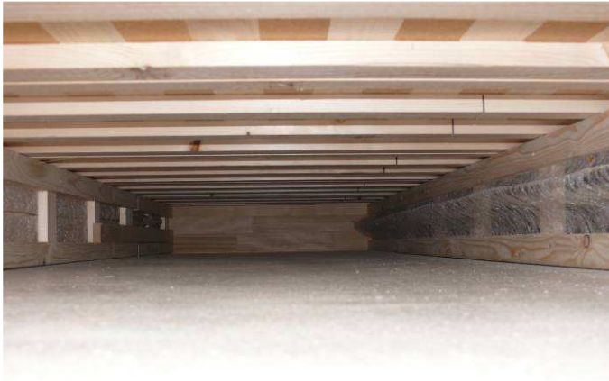
Bild 1: Rahmen mit Tragkonstruktion
