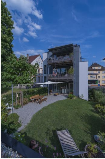
Lignotrend Passivhaus RT_204_Gartenansicht
