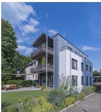
Lignotrend Passivhaus RT_175_Gartenansicht
